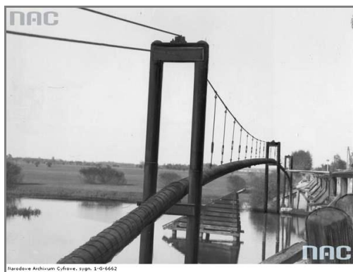
Рис. 7 – Річковий перехід ділянки газопроводу «Дашава – Львів» (фото 1932 р.)
